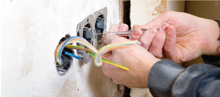
2 | Sonderfachleute, die sich in spezialisierten Tätigkeitsfeldern, wie z. B. Elektrotechnik, Klima, Lüftung oder Sanitär, auf der Baustelle bewegen, obliegen nicht der Baustellenkoordination des AG.
