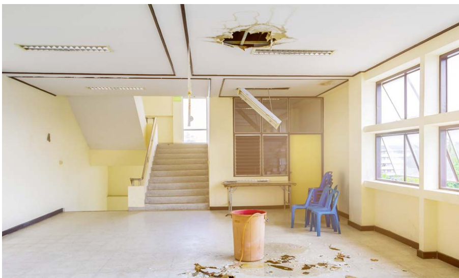
(1) Ein Dach muss dicht sein, selbst wenn es mit einer preiswerten Abdichtung hergestellt wurde. Diese ändert nichts an der gewünschten Funktion, das Gebäude vor Wasser einbrüchen zu schützen.
